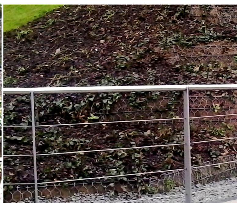
**La finition de surface** est très importante pour le gabion. Comme elle influence directement la résistance à la corrosion du gabion et surtout quand les conditions environnementales sont rigoureuses. (par exemple dans l'eau salée)
