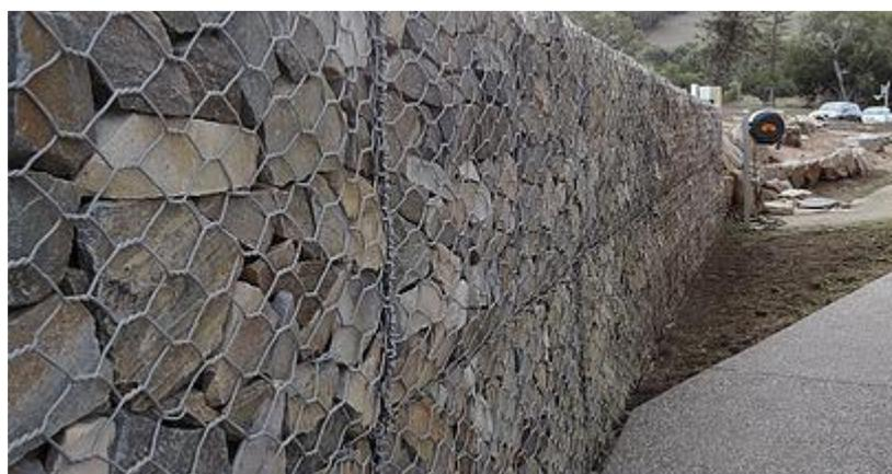
Mur de soutènement de Gabion
